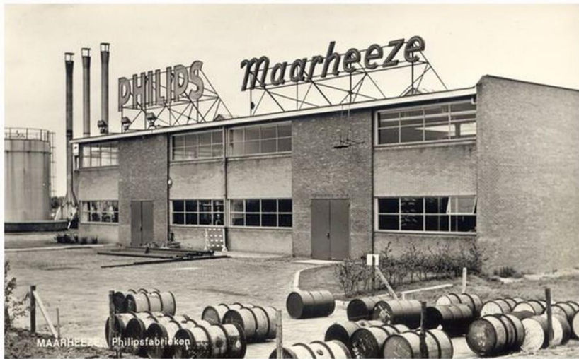
Afb. 7: Philipsfabriek Maarheeze, gebouw B
